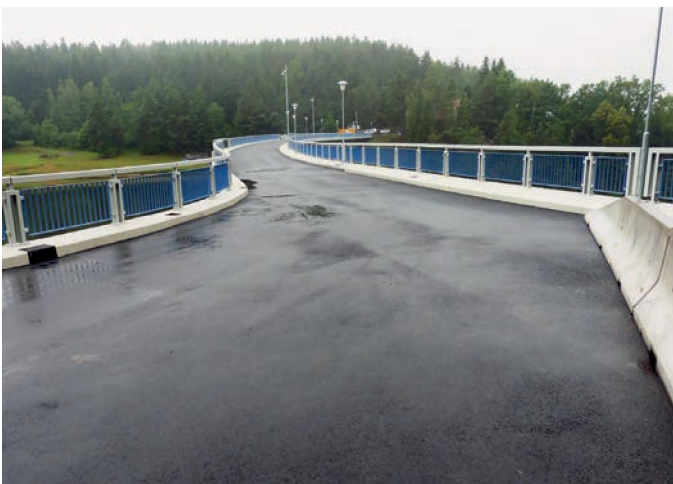
Pohled na novou dokončenou korunu hráze. (archiv Povodí Vltavy, státní podnik)
