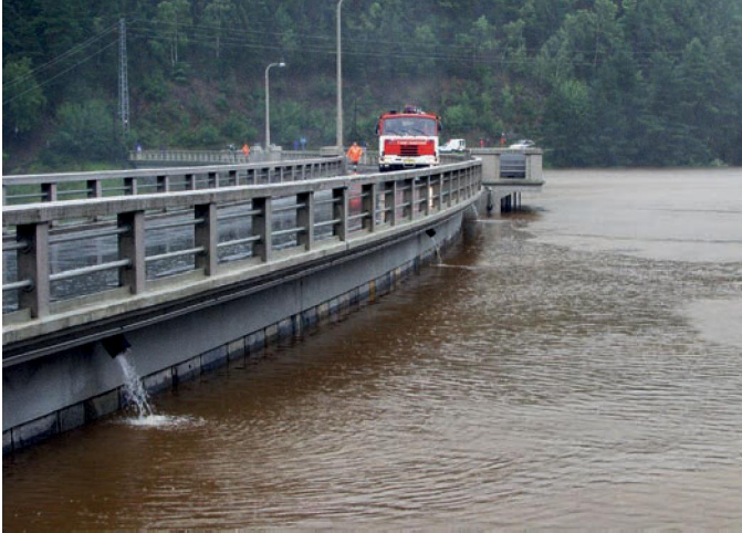
Kulminace povodně 2002 z návodní strany hráze (Archiv Povodí Vltavy, státní podnik)
