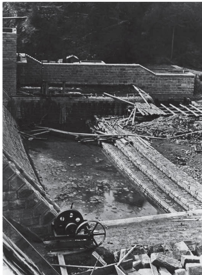
Dokončovací práce na vývaru pod přelivy rok 1937 (archív Povodí Vltavy, státní podnik).
