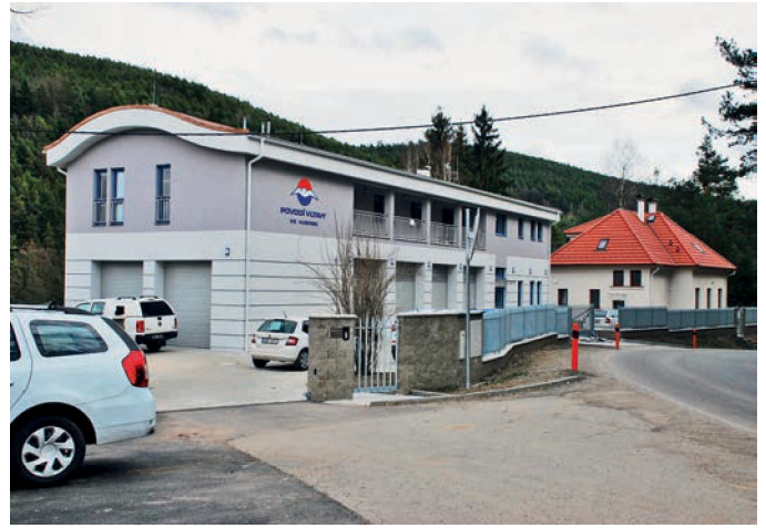
Dokončený provozní objekt (archiv Povodí Vltavy, státní podnik)
