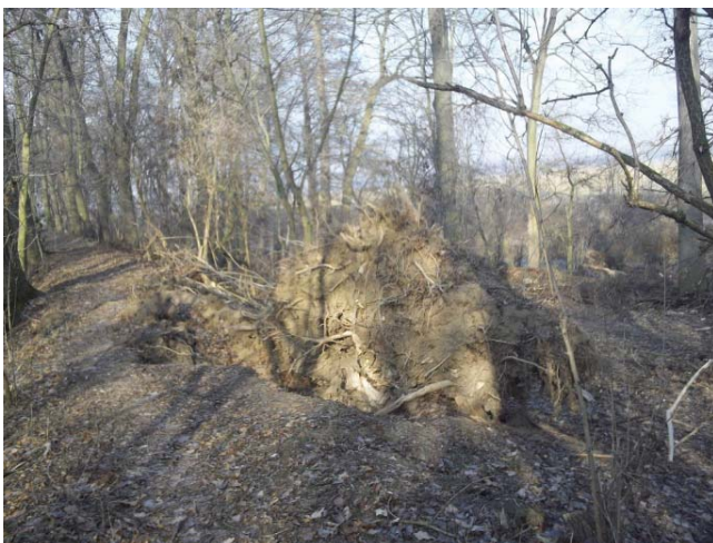
Nebezpečný vývrát stromu na hrázi rybníka
