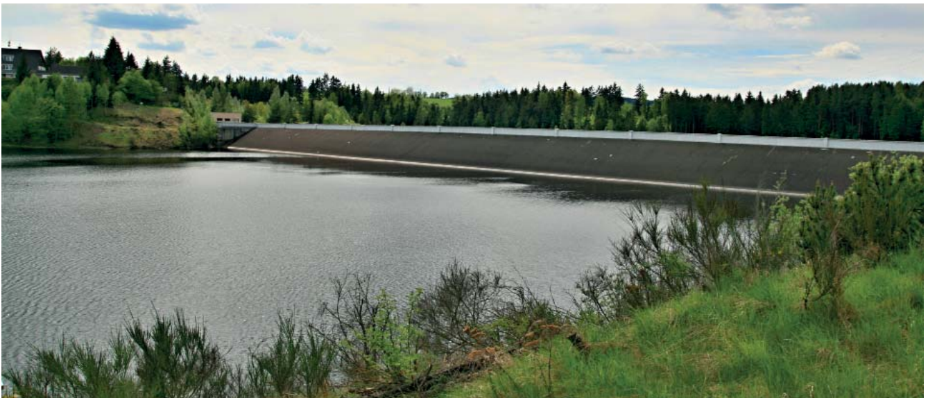
Hráz vodní nádrže
