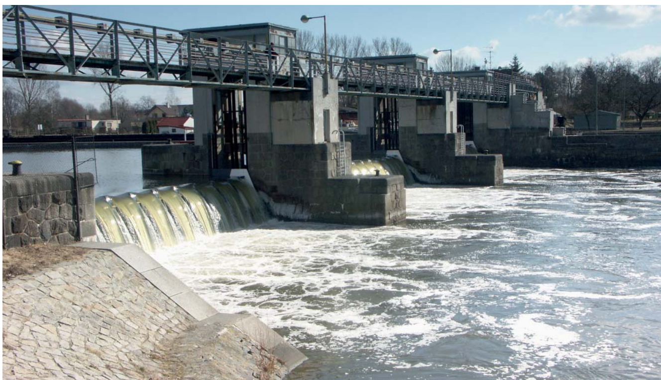
Jez Čelákovice na Labi s malou vodní elektrárnou
