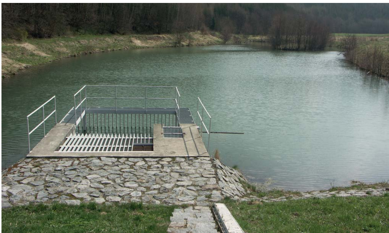
Udržovaný sdružený objekt malé vodní nádrže
