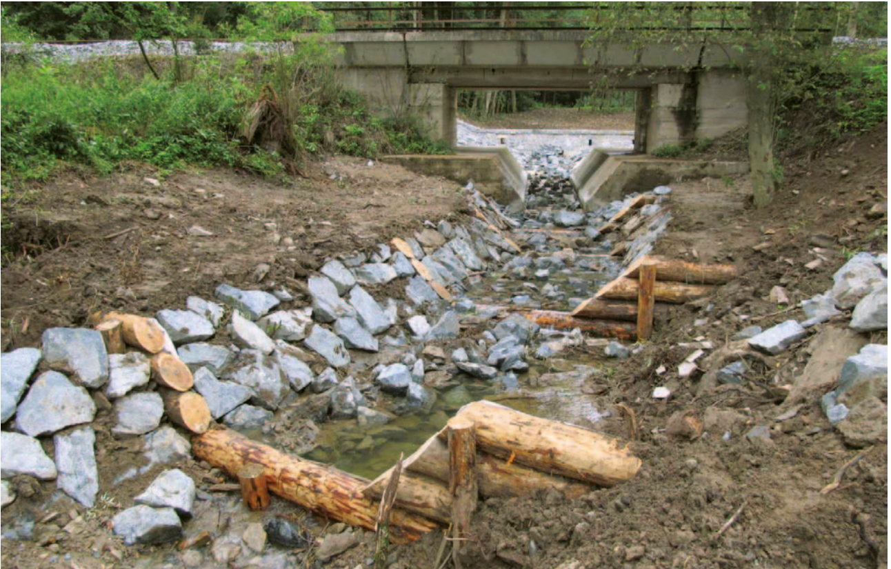
Obrázek 4-5: Pohled proti vodě na soustavu dřevěných stabilizačních pasů, které stabilizují lichoběžníkové koryto zpevněné kamennou rovnaninou. Rovnanina je provedena i ve dně z důvodu tlumení energie vody a ochrany železničního propustku proti zpětné erozi. Dřevěný stabilizační pas je konstrukčně proveden jako jednoduchá srubová stěna. Úseky mezi jednotlivými srubovými objekty jsou vyplněny kamennou rovnaninou v březích i ve dně. Podobná opevnění se doporučují v místech velkého podélného sklonu, kde je zároveň nutné stabilizovat koryto např. z důvodu kontaktu s dopravní infrastrukturou.
