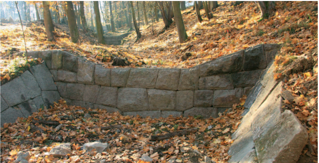
Obrázek 4-11: Pohled na stupeň na vodním toku z kamenicky upravených kamenů. Břehy a dno dopadiště jsou opevněny kamennými deskami.
