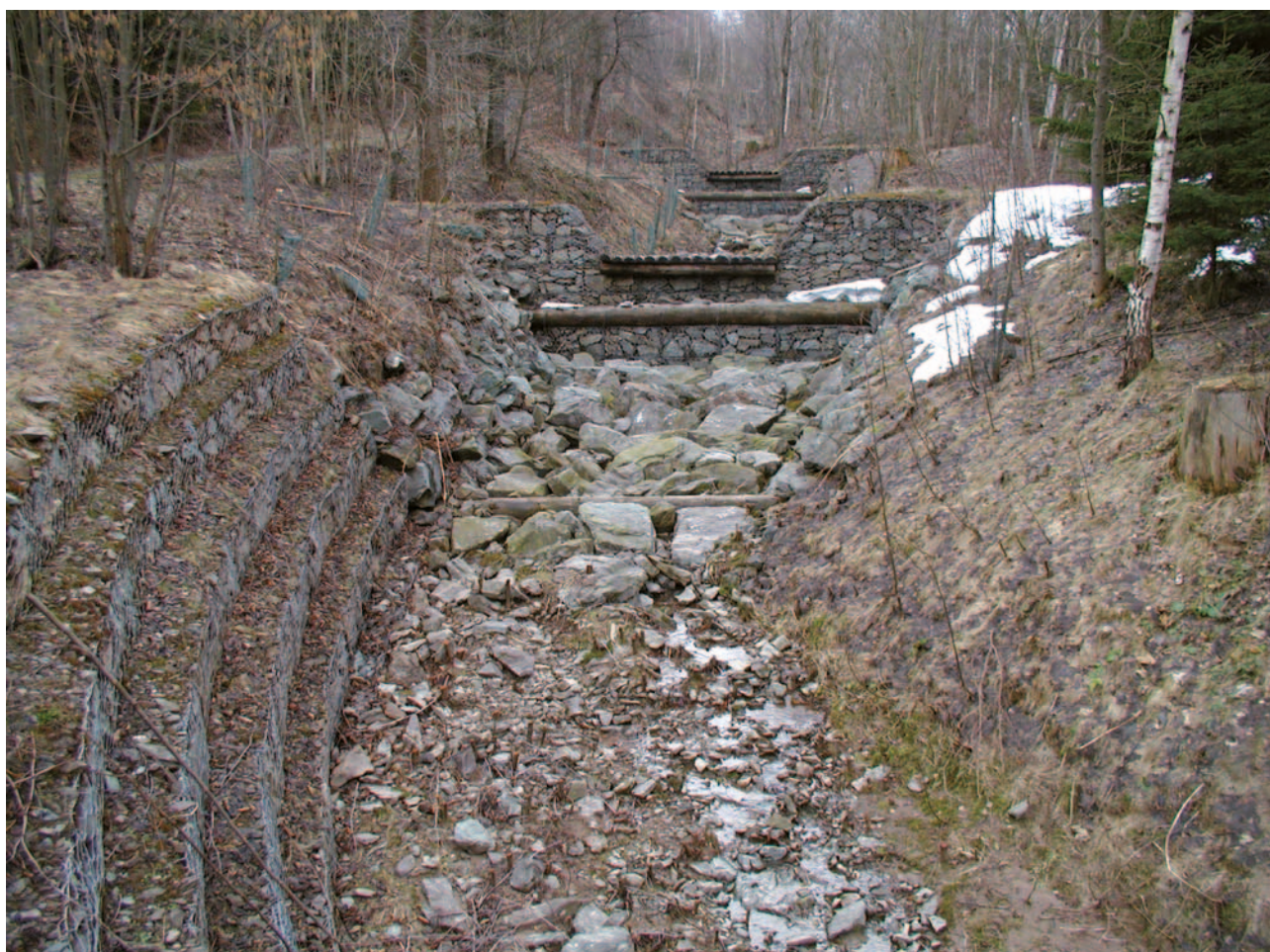
Obrázek 4-49: Pohled proti vodě na soustavu gabionových stupňů se spadišti zpevněnými kamennou rovnaninou v březích i ve dně. Konec spadiště je stabilizován pomocí dřevěných pasů z kulatiny. V místě souběhu lesní cesty s korytem je náporový břeh zpevněn gabionovou stěnou. Přelivná hrana na jednotlivých gabionových objektech je zpevněna půlenou kulatinou, přepad přes spodní gabionový koš je zpevněný příčně položenou kulatinou tak, aby byla ochráněna hrana koše před obrusem. Způsob zpevnění přelivné hrany pomocí stěny z kuláčů, resp. pomocí položeného kmene je možné označit za vhodný.
