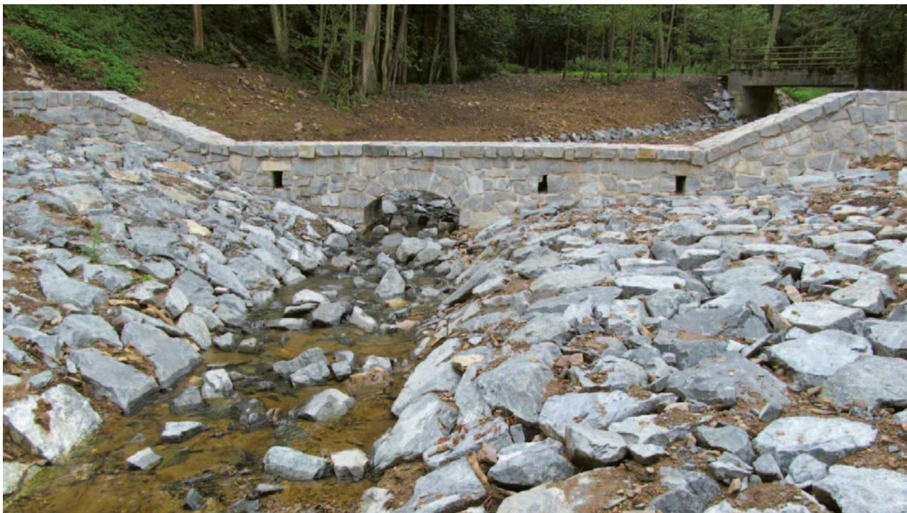
Obrázek 4-21: Pohled na retenční přehrázku s požadavkem na zachování částečné průchodnosti koryta pro rybí obsádku. Dnový otvor je proveden jako dostatečně široká klenba, aby voda mohla bezpečně protékat a ryba se do světlého otvoru dostala. Funkce přehrázky je zaměřená hlavně na snížení energie toku v místě rozšíření retenčního prostoru na konci zdrže, kde přechází koryto do retenčního prostoru (díky rozšíření koryta se snižuje unášecí síla vody a vypadávají první hrubé splaveniny). Tvar a velikost dnového otvoru a následně i celková konstrukce přehrázky umožňuje určitou separaci splavenin a průchod menších splavenin dolů po toku. Díky dlouhým přelivným hraně a snaze o zachování hloubek při běžných průtocích v korytě je patrně poměrně rozsáhlé zpevnění břehu a vytvoření složeného profilu v místě spadiště. Tloušťka konstrukce nad klenbovým otvorem ve dně by z důvodu zajištění statické stability tělesa měla být minimálně 2,5–3,0násobkem velikosti kamene použitého ke zdění.
