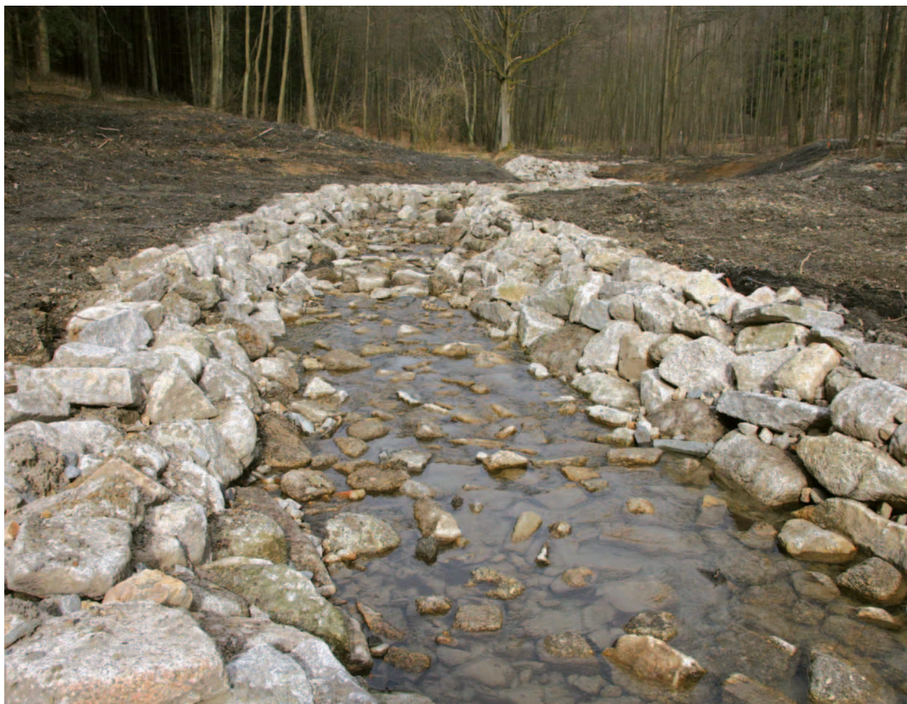
Obrázek 4-51: Pohled na přeložku koryta bystřiny zpět do údolnice. Profil koryta má po úpravě zachovány velkou drsnost (používané kamenné figury bez urovňování líce tlumí pohybovou energii vody). Rovnanina je provedena štětováním kamene do břehu s tím, že spodní kameny jsou zhruba z poloviny uloženy nad niveletu dna a linii běžných průtoků, nedochází tak k vytvoření průběžné spáry mezi dnem a břehem. Při vytváření rovnaniny se zpevněným dnem je nutné eliminovat průběžné dnové spáry (jako první se provede založení rovnaniny břehu, následně se pokračuje s vytvořením zpevnění dna a teprve poté se dodělává nadzákladová rovnanina).
