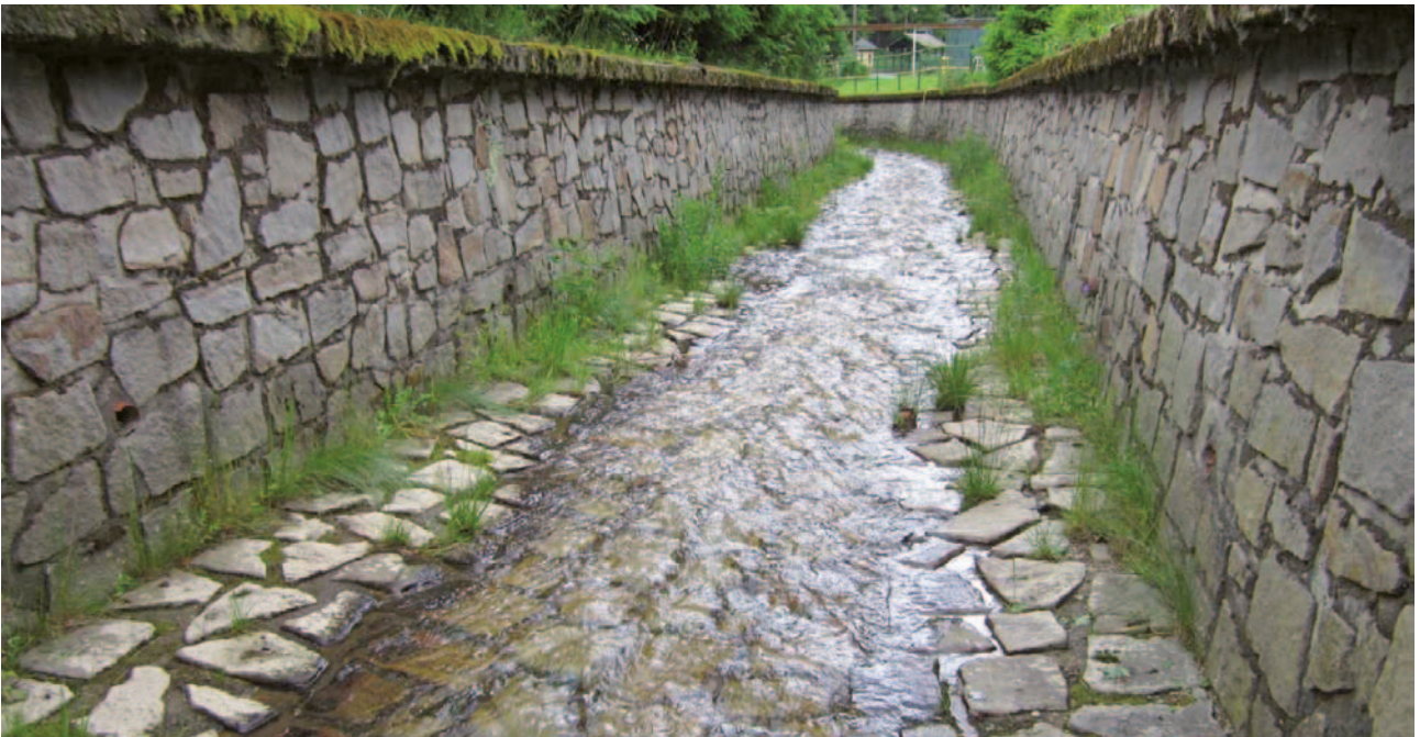
Obrázek 4-53: Úprava profilu koryta typická pro bystrinu vedenou intravilánem. Obdélníkový profil je v březích zpevněn opěrnými zdmi z režného kamenného zdiva, koruna je pak uzavřena betonovou římsou. Ve dně je koryto zpevněné kamennou dlažbou na cementovou maltu s vyspárováním. Z důvodu zachování hloubky při minimálních průtocích je koryto provedeno do středové střelky. Tato směrová a profilová úprava je doporučována většinou v intravilánu v místě, kde je nutné bezpečně provést korytem vysoké povodňové průtoky. Detailně je patrné provedení spárování dlažby ve dně i u opěrných zdí, betonová římsa je o 10 cm předsazená před líc konstrukce zdi (z důvodu ochrany zdi před stékající dešťovou vodou). Spárování kamenné dlažby i zdiva se doporučuje provádět na plocho, spáru zhruba o 1 cm zatlačit pomocí spárovaček pod líc kamenného zdiva.
