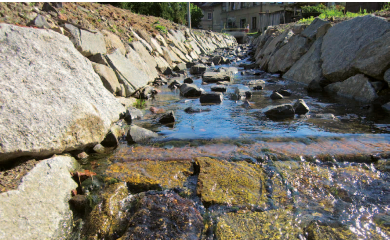
Obrázek 4-4: Pohled proti vodě na přechod dna koryta ve skluz, břeh je opevněn kamennou rovnaninou klínovanou kamenem. Opevnění dna v horní trati koryta je provedeno velmi hrubé z důvodu snížení energie vody, následně je sklonový přechod zpevněn dřevěným pasem z hraněné kulatiny, v březích je pas zatížený kamennou rovnaninou. Stabilizace pasem ve dně je nutná z důvodu změny rychlosti proudění vody na přechodu sklonů (dalšími místy, kde se používá stabilizační pas, jsou místa přechodu jednoho typu opevnění v jiný).
