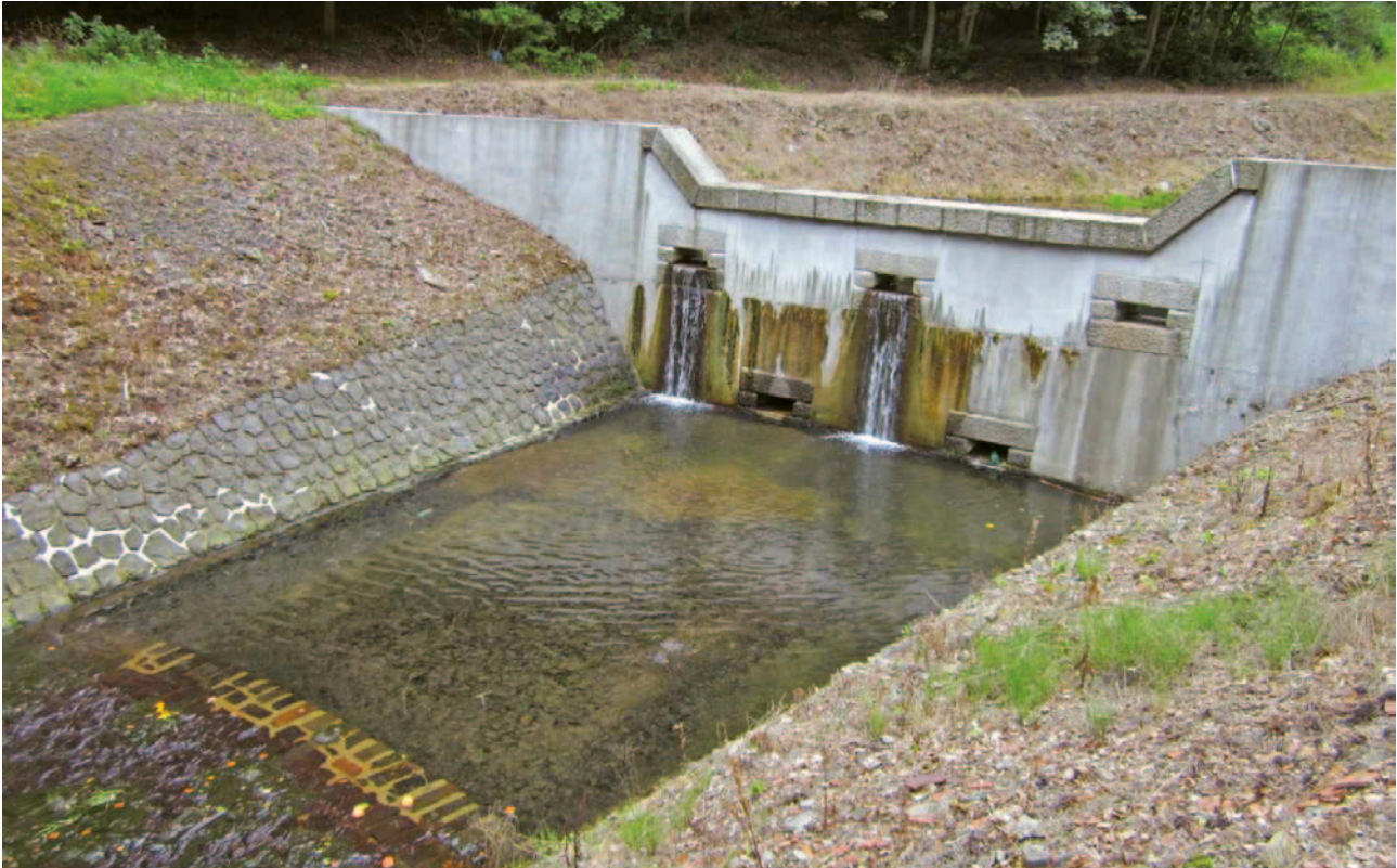
Obrázek 4-23: Pohled proti vodě na betonovou retenční přehrážku vybudovanou do systémového bednění s tím, že v tělese přehrážky jsou průřezné otvory ve dvou úrovních tvořené pískovcovými bloky. Přelivná sekce je na přelivu zpevněna pískovcovými bloky, které jsou mírně předsazeny před přeliv. Spadiště se nijak zásadně nerozšiřuje, z toho důvodu je opevnění v březích provedeno kamennou dlažbou ze sloupkového čediče na cementové lože s vyspárování do výškové úrovně druhých oken tak, aby voda přepadající přes přelivnou sekci dopadala již na zpevněný břeh. Objekt je na spodní části po vodě ukončen stabilizačním pasem. Na konstrukci je patrný průsak špatně ošetřenou pracovní spárou vzniklou při postupném betonování tělesa přehrážky.
