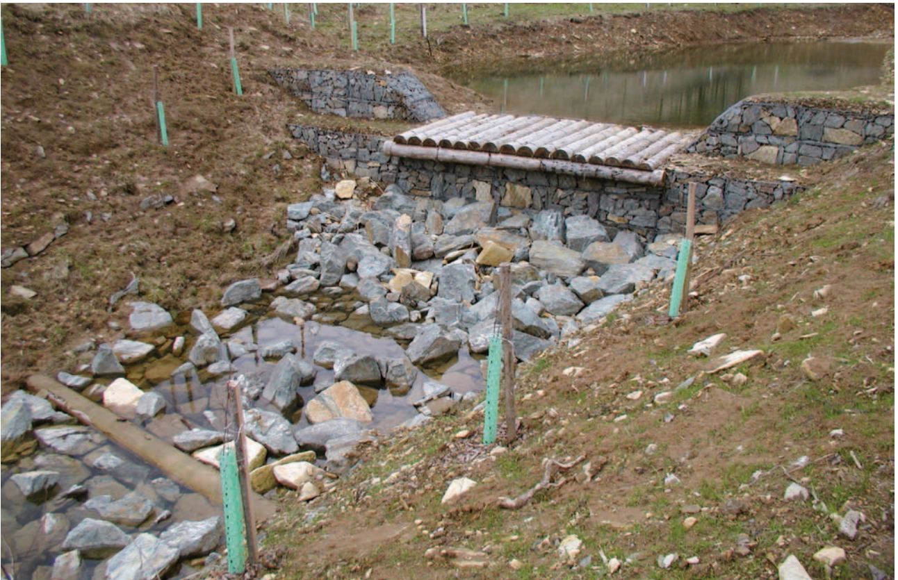
Obrázek 4-33: Pohled proti vodě na konstrukci přehrážky z gabionových košů, kde přelivná hrana přepadové sekce je chráněna dřevěnou konstrukcí z půlené kulatiny. Zároveň je dřevěná konstrukce přetažena přes celou gabionovou přelivnou část. V porovnání s dřevěnou konstrukcí z prken (obr. 4-31) je použití kulatiny vhodnější. Zároveň díky této konstrukci, kdy je chráněná „pouze“ přelivná hrana, je možné snadno dřevěný ochranný prvek vyměnit za nový. Spadiště je zpevněno ve dně těžkým kamenným záhozem, který je na spodní části po vodě ukončen a stabilizován dřevěným stabilizačním prahem z kulatiny. Břehy jsou zcela nezpevněné, ponechané pouze sukcesi. Takovou úpravu spadiště umožňuje profil terénu pod objektem. Z důvodu velkého namáhání paty břehu se v místě přechodu břehu do dna doporučuje minimálně zpevnění paty břehu kamennou rovnatinou, popř. kamenným záhozem.
