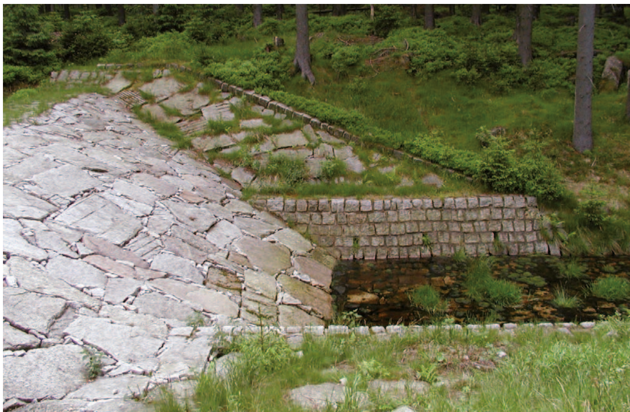
Obrázek 4-72: Průsaková hráz na vodním toku Jeřice v Jizerských horách, pohled na povodní stranu (vzdušní líc), patrná je kamenná dlažba líce.
