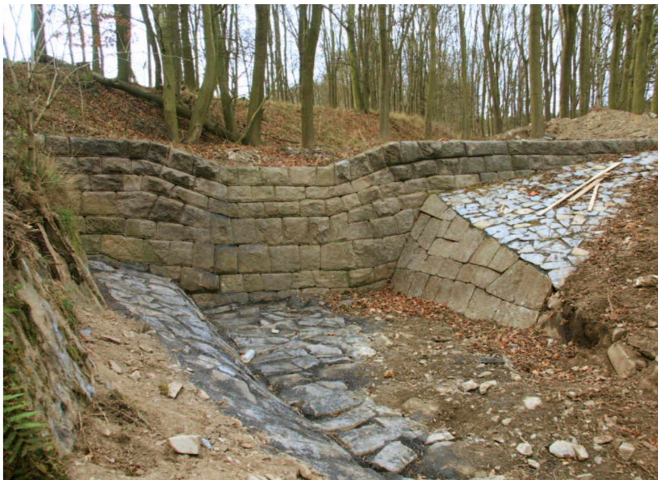
Obrázek 4-18: Pohled na konsolidační přeřázku na levobřežním přítoku Struhařského potoka. Patrná je absence průcezných otvorů. Kamenná konsolidační přeřázka je provedena z kamenného zdiva, resp. kamenicky upravených kopáků zděných na sucho. Výhoda na sucho skládaných konstrukcí spočívá v tom, že kámen zůstává „poddajný“ ke změně tvaru podloží vznikající díky zamrznutí vody v půdě (dochází k pohybům v celém objektu). V případě neodborného zásahu, kdy je například koruna dodatečně vyspárována cementovou maltou, se vytváří v jinak poddajná konstrukci zděný věnec, který neumožňuje pohyb kamene v celé konstrukční výšce objektu. Takový zásah vede k postupné destrukci přeřázky díky tomu, že se pohybem země při jejím zamrznutí dostávají nebo nadzvedávají jednotlivé konstrukční kameny přeřázky, které pak shora naráží na věnec. Pohyb konstrukčních kamenů nahoru je tak omezený a kameny se postupně vyvalují z konstrukce, která se díky tomu rozpadá.
