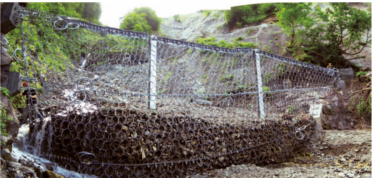
Obrázek 4-68: Ukázka zachycení splavenin pomocí dynamické bariéry UF 180 H6.
