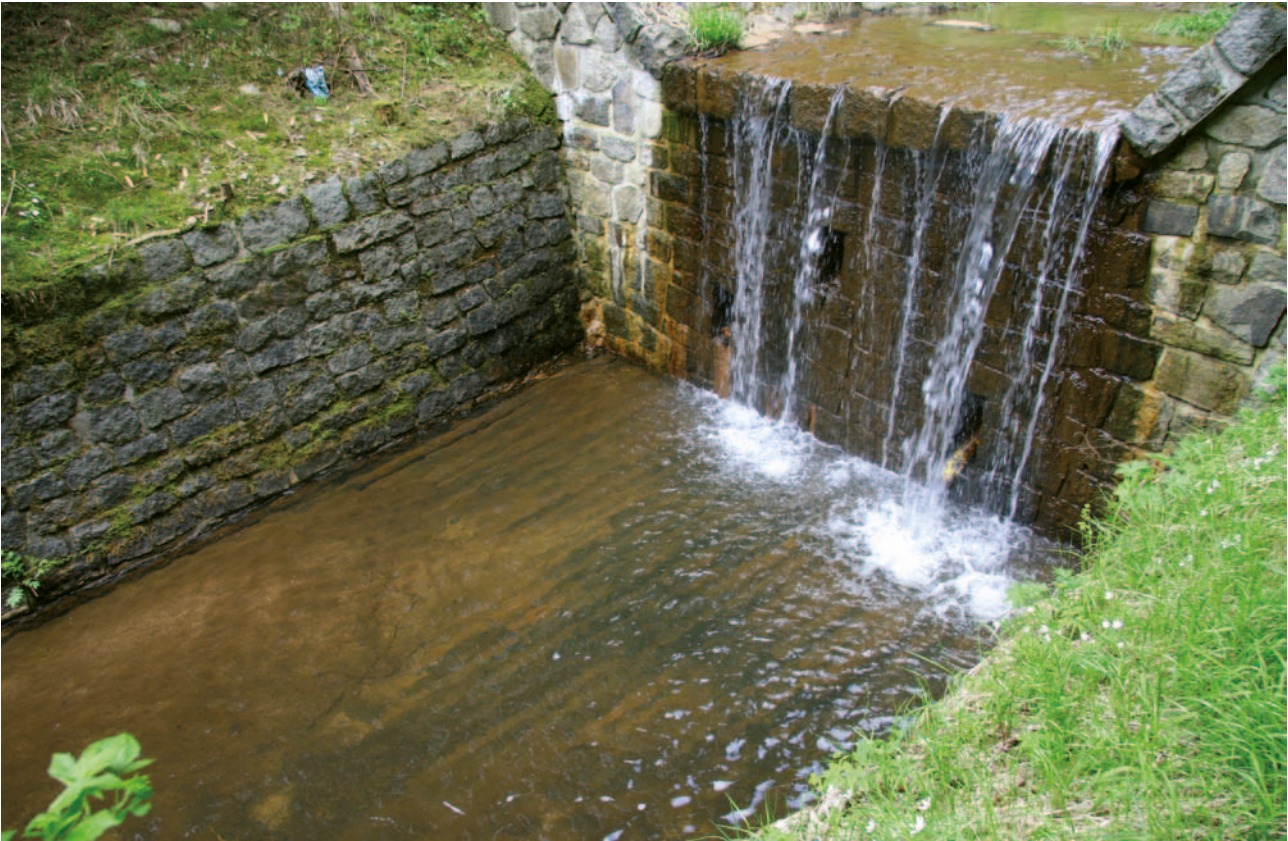
Obrázek 4-14: Pohled na konstrukci stupně se spádovou výškou kolem 2 m a zpevněním spadiště pomocí tyčoviny. Jedná se o historický objekt s předsazenou přelivnou hranou, zpevněnou pomocí kamenných desek, s břehy opevněnými kamenným zdivem. V konstrukci stupně jsou patrné odvodňovací otvory, spadiště je zpevněné tyčovinou (v současné době se provádí pouze u historických oprav většinou z důvodu možného porušení tyčí v případě průchodu velkých splavenin a jejich dopadu do spadiště). Uvedené opevnění dna je vhodné pouze v případě, že je zajištěna stabilní hloubka vody (např. díky mírnému protisklonu spadiště) nebo v případě, že korytem neprochází splaveniny větší než 15 cm.
