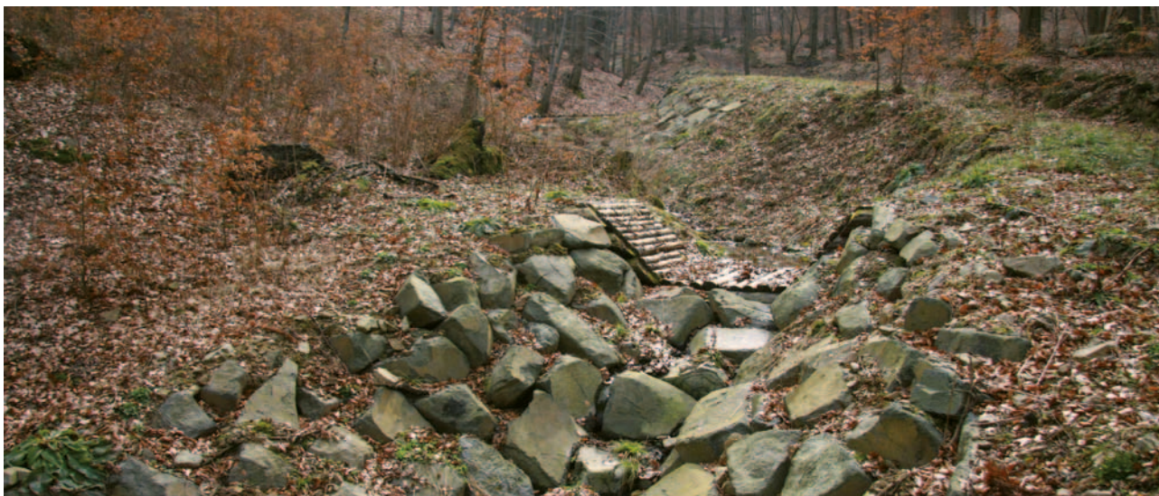
Obrázek 4-16: Pohled proti vodě na stabilizaci dna a břehu v nátrži vzniklé ve velmi výrazné údolnici. Na srubový pas navazuje skluz zesponu opřený o kamenný rovnaný pas. V horní části je strž stabilizovaná pomocí srubové konstrukce z kulatiny vyplněné uvnitř kamennou výplní, přelivná sekce je zpevněna pomocí konstrukce z tyčoviny. Dřevěná konstrukce z tyčoviny má zabraňovat přímému natékání vody do středové části srubu vyplněného kamenem.
