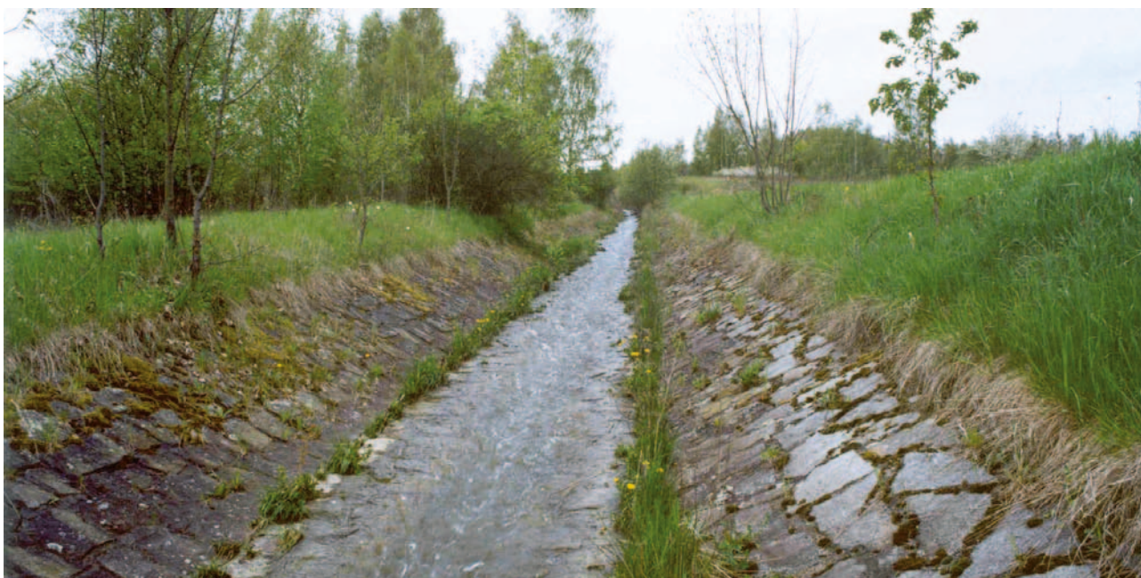
Obrázek 4-45: Opevnění podhorského potoka kamennou dlažbou do betonu.
