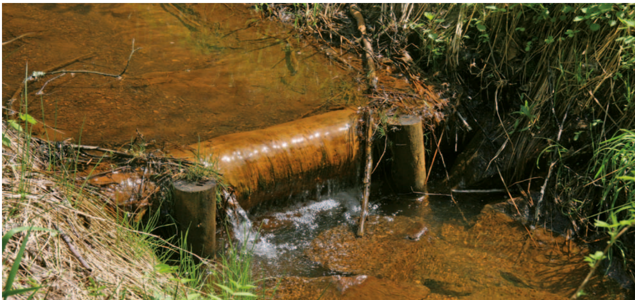
Obrázek 4-9: Pohled proti vodě na klasický stabilizační práh upravující niveletu vodního toku. Z fotografie je patrné uchycení příčně položené kulatiny za dvojici dřevěných pilot a zpevnění spadiště kamenným záhozem, kamennou dlažbou nebo rovnaninou. Výška takových prahů se pohybuje okolo 25 cm.
