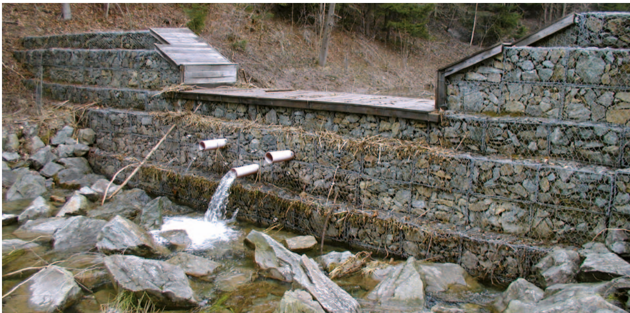
Obrázek 4-34: Pohled proti vodě na těleso retenční přehrážky, kterou tvoří gabionové koše vyplněné poměrně jemným kamenem. Přehrážka má pět výškových úrovní, které jsou na povodňové straně vždy o polovinu koše odsazeny. Pro provádění běžných průtoků tělesem jsou osazeny 3 plastové trouby, které jsou dostatečně protaženy před gabion, takže při průtoku dochází k dopadu vody do spadiště zpevněného těžkým záhozem. Přelivná sekce je obdélníková, následně přechází v lichoběžník. Přelivná hrana i boky přelivu jsou zpevněny pomocí prkenné podlahy. Z fotografie je patrné, že při velkém průchodu přetéká voda přes spodní koše, při posunu hrubších splavenin v paprsku vody přes hranu spodních košů může docházet k abrazi drátů. Je také patrné, že na předsazených gabionech dochází v době zvýšených průtoků k zachycení vegetačních zbytků a plávi neseného vodou.
