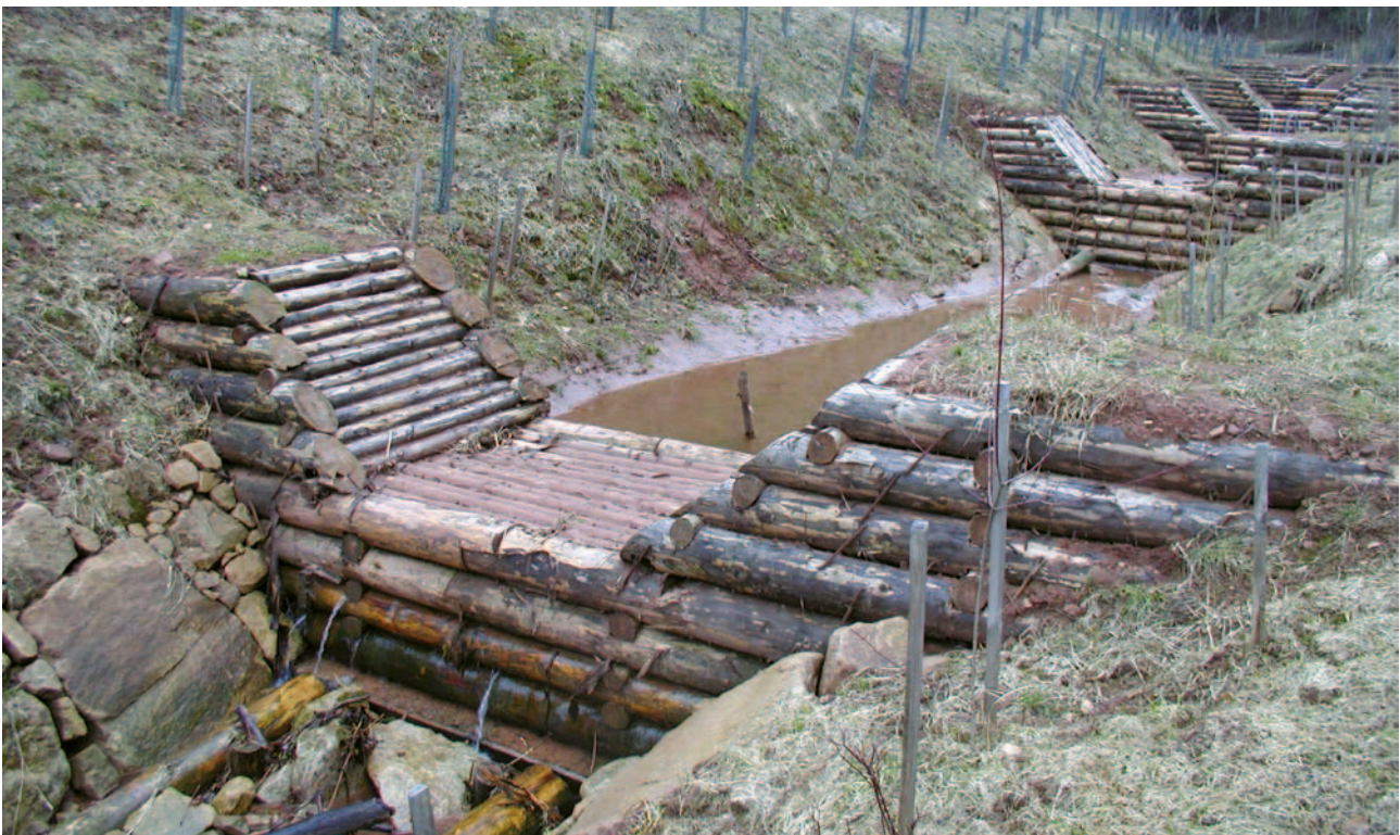
Obrázek 4-37: Pohled na konstrukci srubové přehrážky.
