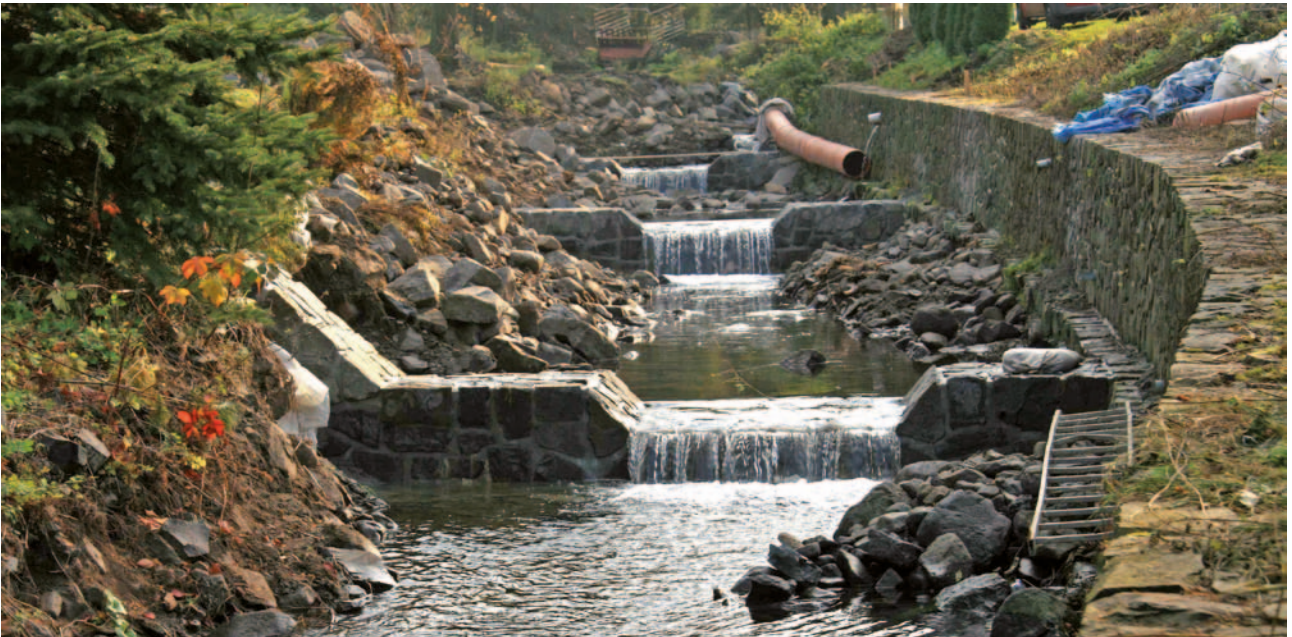
Obrázek 4-7: Pohled proti vodě na výstavbu soustavy stabilizačních prahů s kynetou pro převod běžných průtoků; mezi pražky proveden zához ve dně, břehy opevněny opěrnou zdí a kamennou rovinaninou.
