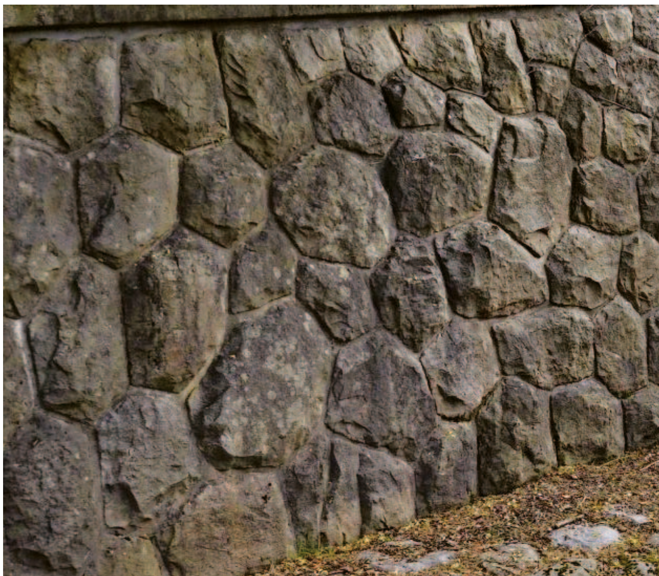
Obrázek 4-61: Ukázka cyklopského zdiva použitého u opěrné nábrežní zdi.
