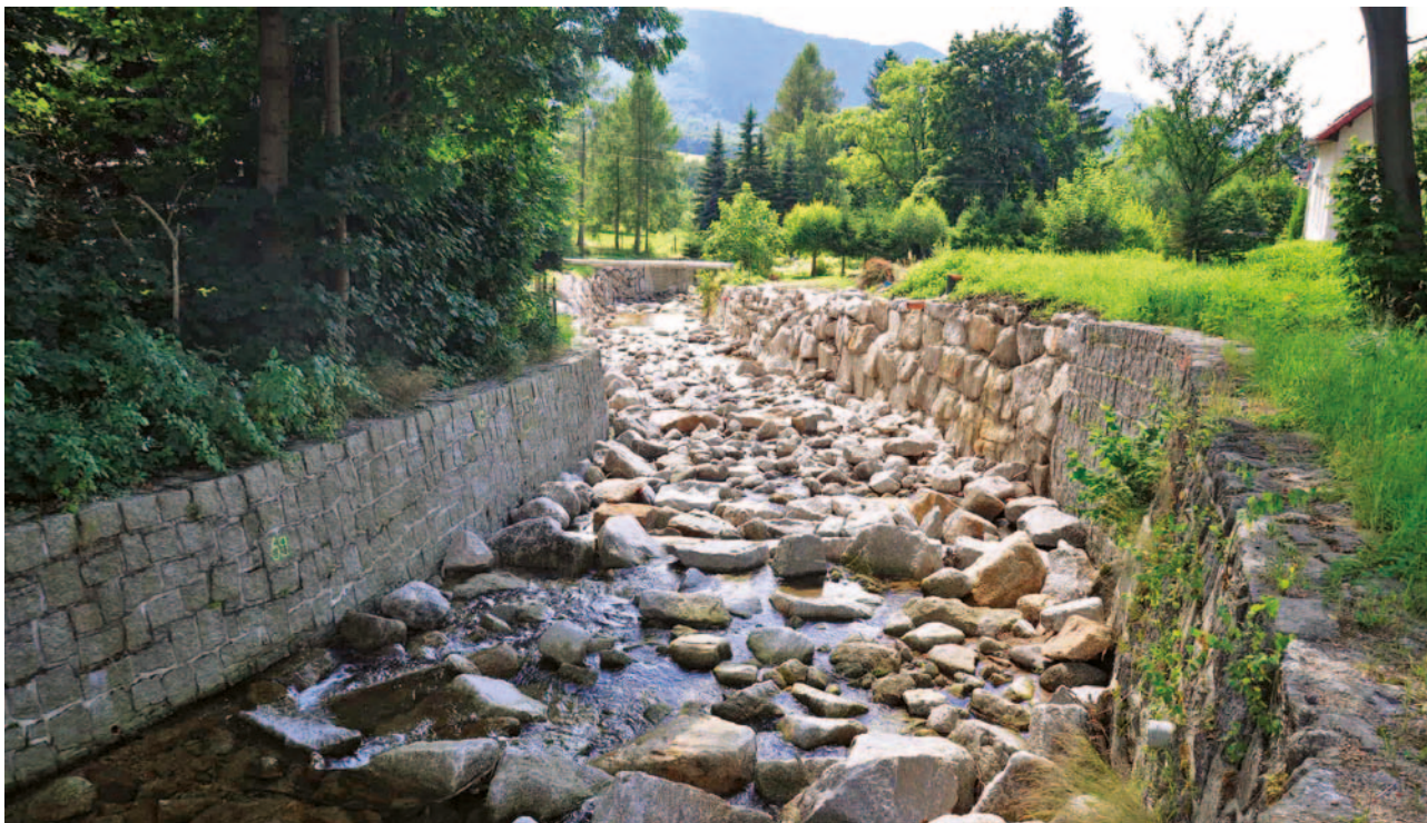
Obrázek 4-15: Betonový stabilizační pas s úpravou přelivu hrubými kameny, na který navazuje balvanitý skluz z kamenů kladených do dna na štět (autor: Lesy České republiky, s. p. – Odbor vodního hospodářství). Při nízkovodných stavech jsou objekty tohoto typu díky použití velkých kamenů migračně neprůchodné z důvodu zaklesnutí vody mezi kameny a často i pod ně.
