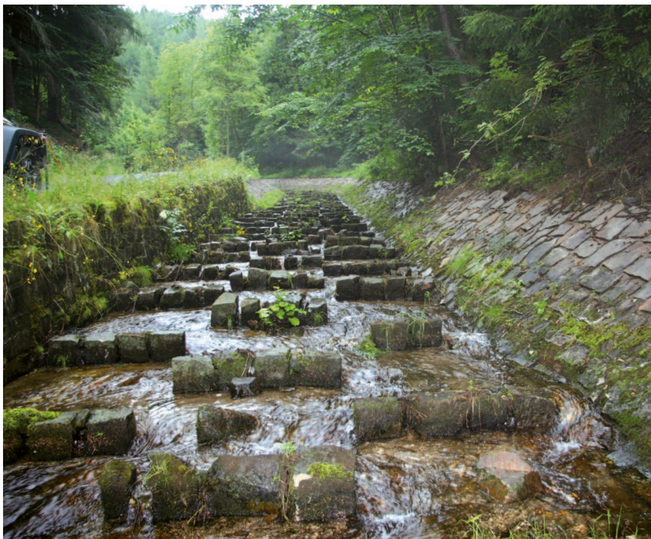
Obrázek 4-48: Koryto horské bystřiny s úpravou pro zvýšení drsnosti pomocí umělých rozvaděčů vytvářejících šachovou figuru vystupujících žulových kostek, kamenných kvádrů nebo kopáků (kotvení do dna je nutné na minimálně polovinu výšky kamene). Původní lichoběžníkový profil koryta zpevněný v březích i ve dně kamennou dlažbou na cementovou maltu s vyspárováním přechází v místě přiblížení se k silnici v opěrnou zeď stavěnou z hrubého řádkového zdiva. Celkově se jedná o úpravu podélného i směrového vedení koryta. V současné době se při hrazení bystřin tato úprava z důvodu její tvrdosti a čistě technického charakteru nepoužívá.
