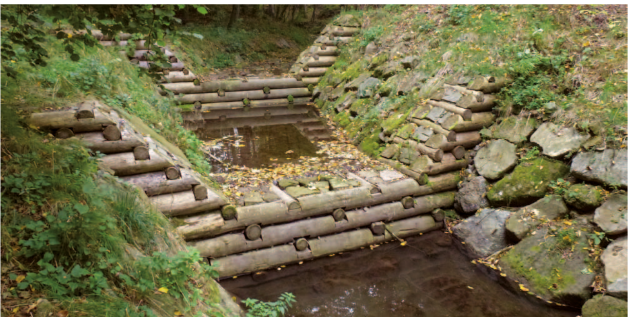
Obrázek 4-12: Soustava srubových stupňů se spadištěm opevněným ve březích kamennou rovnatinou (autor: Lesy České republiky, s. p. – Odbor vodního hospodářství).
