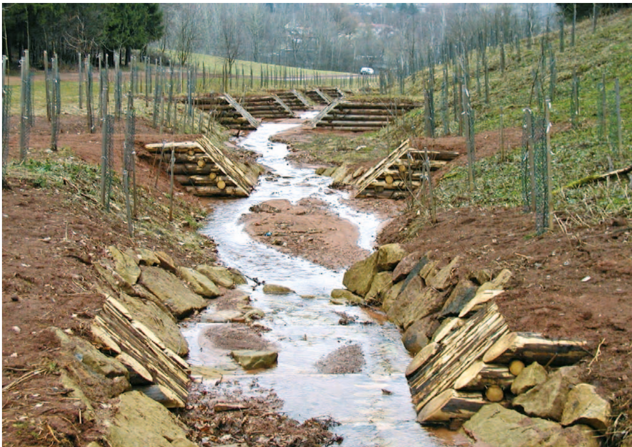
Obrázek 4-39: Soustava srubových pasů vyplněných kamenem pro stabilizaci koryta s výraznou břehovou a dnovou zpětnou erozí protékající vodu. Přelivná část je v koruně i ve březích zpevněna pomocí fošen nebo tyčí.
