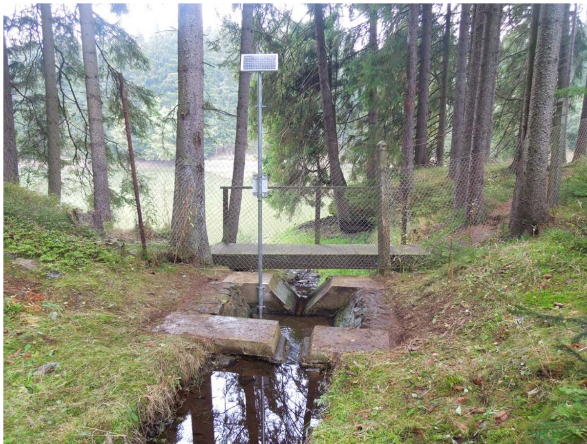
Obr. 1: Měrný přeliv povodí Na zeleném ve Slavkovském lese, vybavený od 30.9.2014 tlakovým čidlem Fiedler na měření vodní hladiny.
