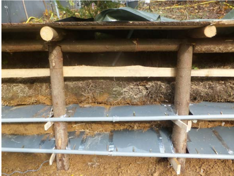
Obr. 2: Zabudování žlábků v zářezu svahu
