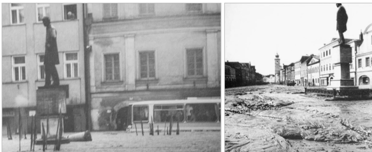
Obr. 5: Zaplavení náměstí při bleskové povodni v Litomyšli v květnu 1984.
