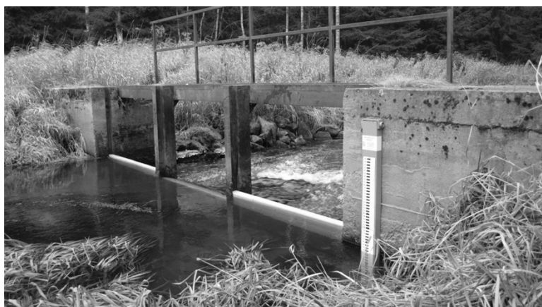
Obr. 2: Vodoměrná stanice na Kateřinském potoce osazená měrným přelivem za využití stávajícího objektu.
