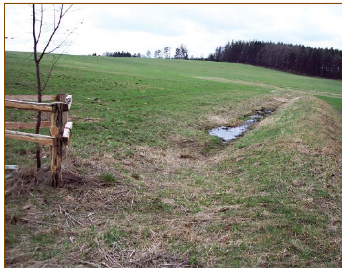
Obr. 4-18: Průleh (Milínov, foto VÚMOP, v.v.i.). Tento průleh nesplňuje díky hrázce s příliš strmými svahy základní podmínku průlehu – tedy možnost přejet mechanizací. Stejně tak by bylo možno ho nazvat mezí se záchytným nebo svodným prvem nebo zemní hrázkou s příkopem. Val by mohl být osázen vegetací.
