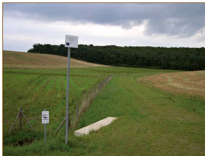
Obr. 4-20: Ochranná hrázka (Hlubočany, foto VÚMOP, v.v.i.). Na návodní straně nemá hrázka travní pás, po kterém bude stékat zadržovaná voda podél hrázky. Voda tak poteče po poli, které bude erozně poškozovat.
