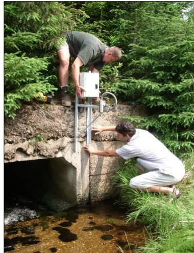
Instalace Hladinoměru
