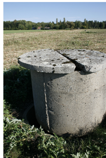
Obr. 1a, 1b: Příklad nadzemní drenážní šachtice. Vstup do šachtice musí být zakryt (betonovým) víkem.
