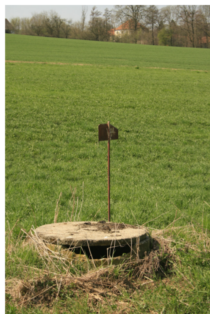
Obr. 1a, 1b: Příklad nadzemní drenážní šachtice. Vstup do šachtice musí být zakryt (betonovým) víkem.
