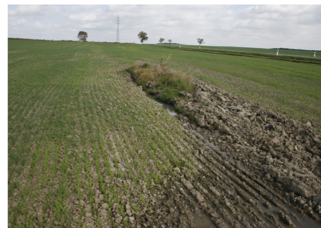
Obr. 2a, 2b: Projevy lokálních poruch na drenáži. Vlevo: vývěr drenážní vody na povrchu pozemku vlivem zborcení drenážky na svodném drénu (SV od obce Opařany, okr. Tábor) s projevem vodní eroze. Vpravo: lokální zamokření způsobené zanesením svodného drénu půdními částicemi (u obce Tupadly, okr. Čáslav), projevující se na zasetém a vzešlém porostu.
