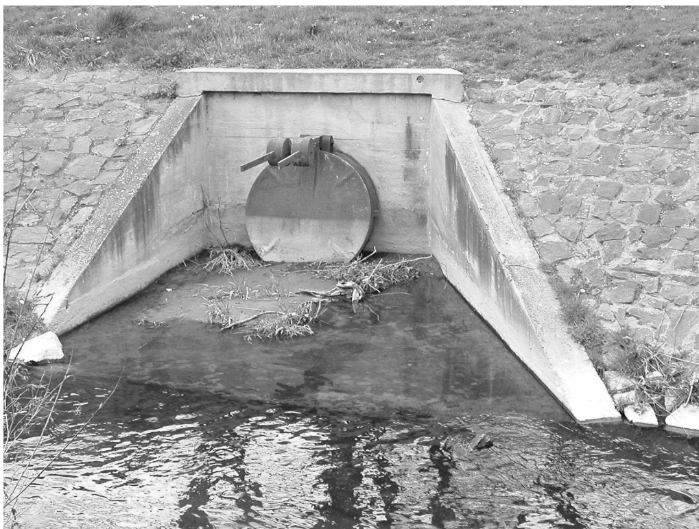
Obr. 10: Kanalizační výust' do vodního toku
