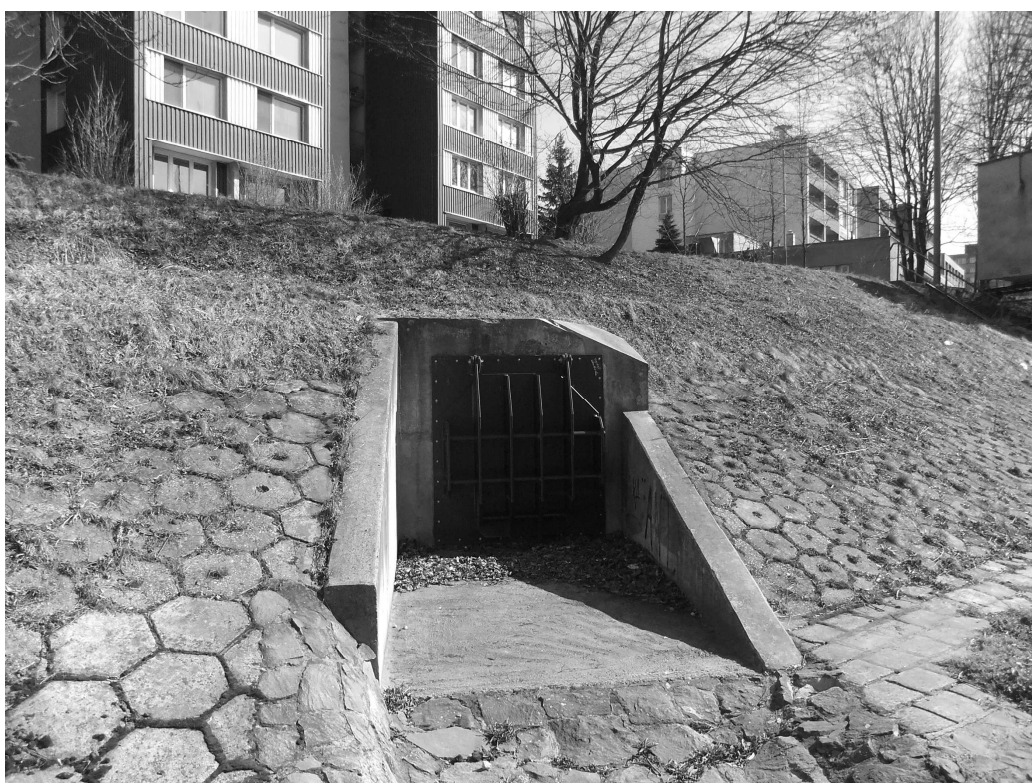
Obr. 1: Výust' z odlehčovací komory jednotné kanalizace do recipientu
