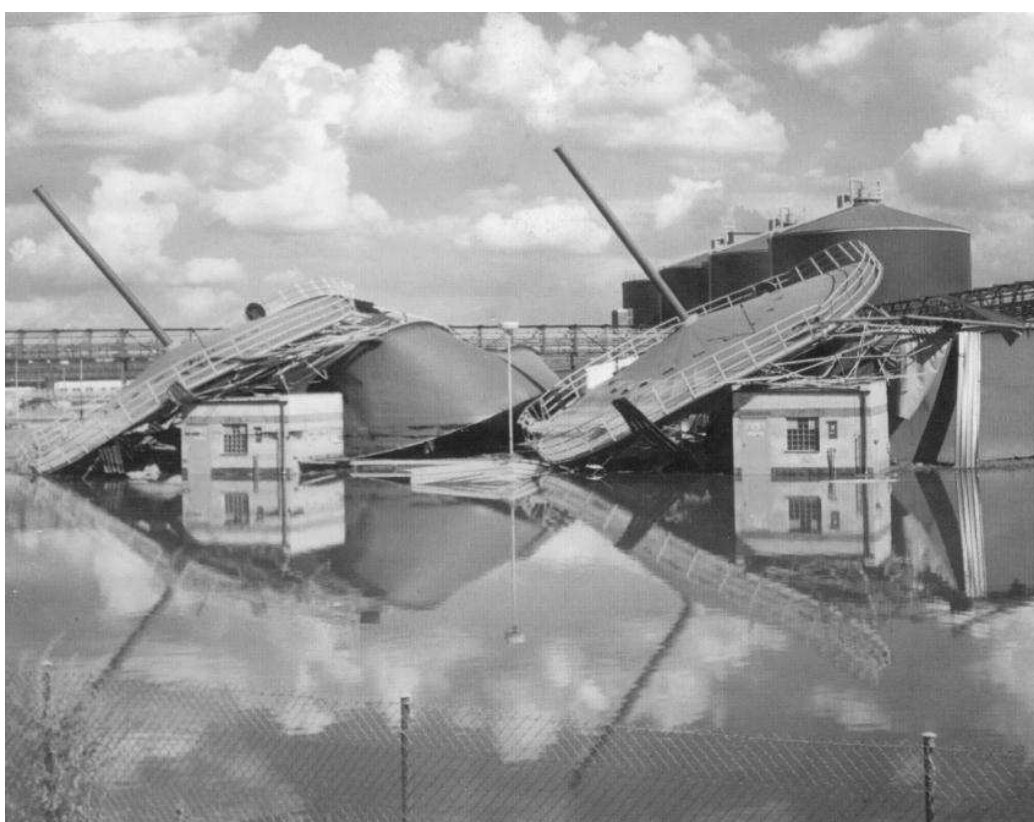
Obr. 5: Destrukce plynojemu ČOV vlivem povodně v Ostravě v roce 1997 [Ondeo Suez, [online] 2007]
